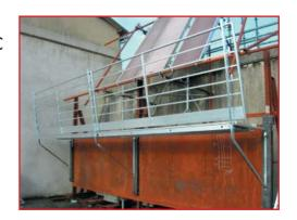
► Ancrage à vis muni d'un écrou à manette résistant et d'une contreplaque pour répartir les efforts.
